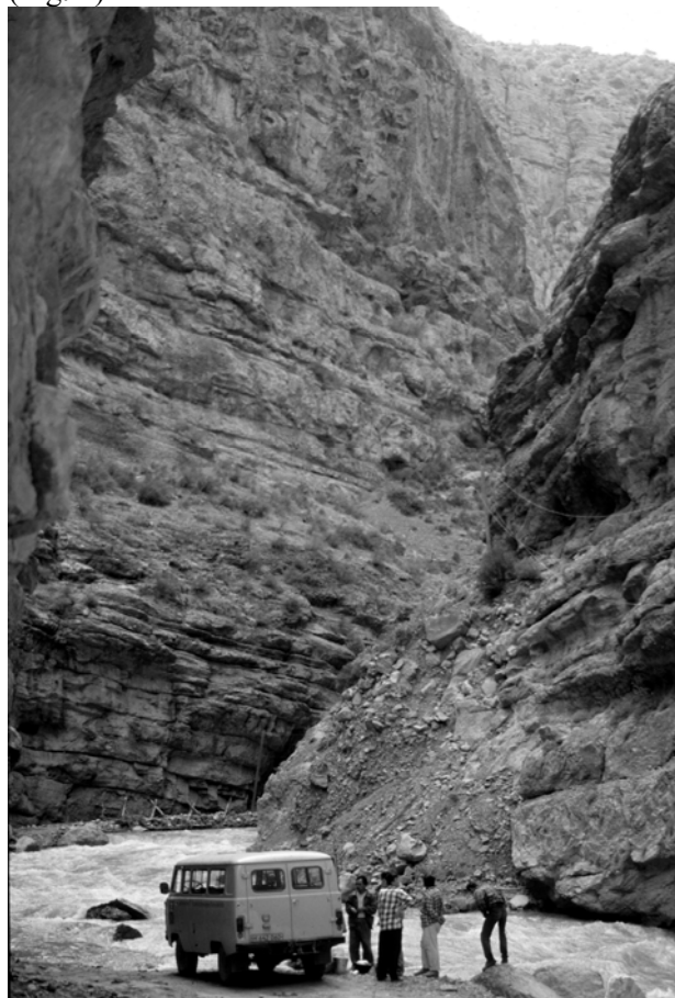
5) Gorge du Sherabad-darya au nord de Derbent: la route emportée par les crues du printemps avec, au fond, les vestiges de la carcasse de troncs constituant le support du parapet de pierres (mai 1997) (vu du sud).
